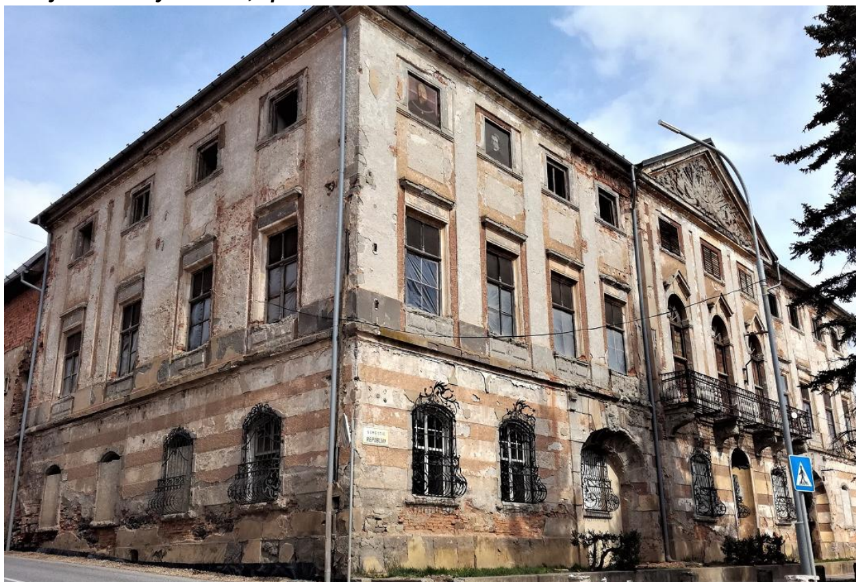
Južný roh fasády kaštieľa, apríl 2023:
