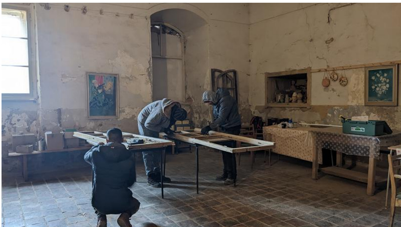
Priebeh prác na obnove rámov pred zasklievaním, náš zámer je postupne všetky zámurovky okenných otvorov na 1NP kaštieľa s osadenými mrežami vybúrať a nahradiť oknami:
